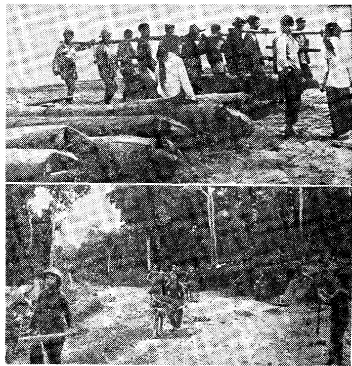
DVA ZNACILNA POSNETKA IZ BORBE SEVERNEGA VIETNAMA PROTI AMERIŠKI AGRESIJI: UDARNE SKUPINE HITIJO POPRAVLJAT BOMBARDIRANE CESTE. V TEH SKUPINAH JE NAJVEČ DEKLET. NA ZGORNJI SLIKI VIDIMO SKUPINO, KI SE PRIPRAVLJA NA GRADNJO LESENEGA MOSTU. NA SPODNJI PA SO DEKLETA MED DELOVNO AKCIJO NA CESTI
