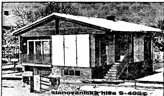
stanovanjska hiša S-405/C
