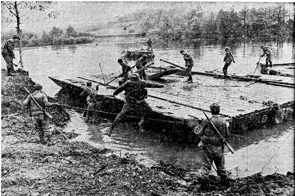
Pontonorji ob sestavljanju mostu čez Kolpo
