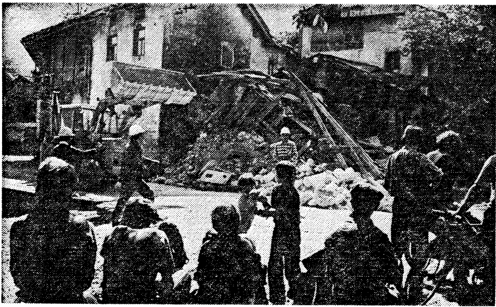
Dva dni po rušilnem potresu so tudi v Idrskem začeli odstranjevati ruševine.
