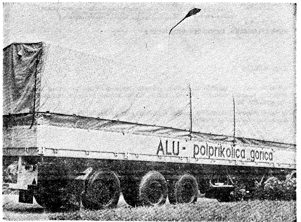
ALU – polprikolica „GORICA“, nosilnost 26 t (v celoti izdelana iz aluminija)
