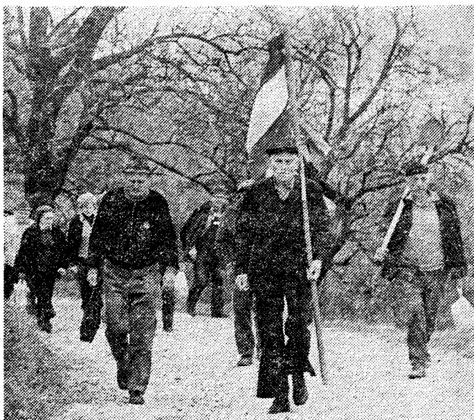
Z jugoslovansko zastavo na čelu, se je kolona borcev podala na gradbišče.
