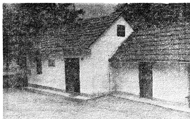
Hiša Ane Kostanjšekove na Trebčah, ki je preurejena v muzej, Trebče pa postajajo urejen spominski park
