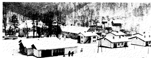
V Loki pri Žusmu je Marles zgradil prvo šolo na Kozjanskem po potresu in tudi vas, ki je in bo ena najlepših ne samo na tem področju, ampak tudi v Sloveniji, saj je še obdržala mnoge prvine prave kozjanske vasi v nekoliko sodobnejši podobi.
