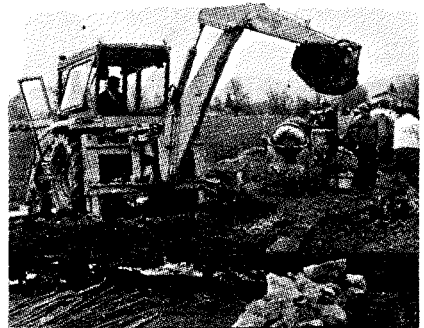
Prostovoljno udarniško delo na mostu čez Farjavec v Kozlarjevi gošči
