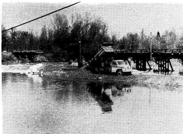
Stari leseni borlski most čez Dravo je odslužil. Poleg njega bo do letošnjega dneva republike zrasel nov betonski
