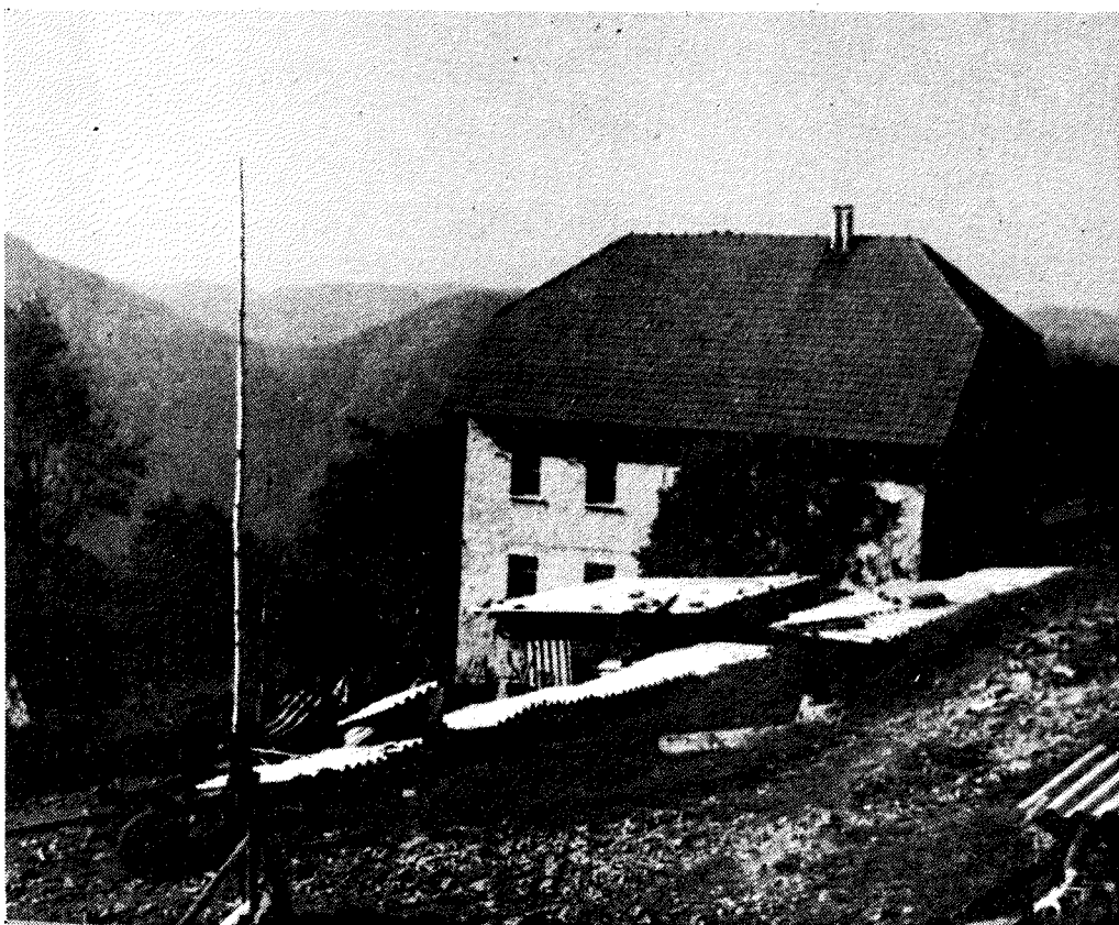
Po desetih letih je bila Čibejeva hiša delno obnovljena
