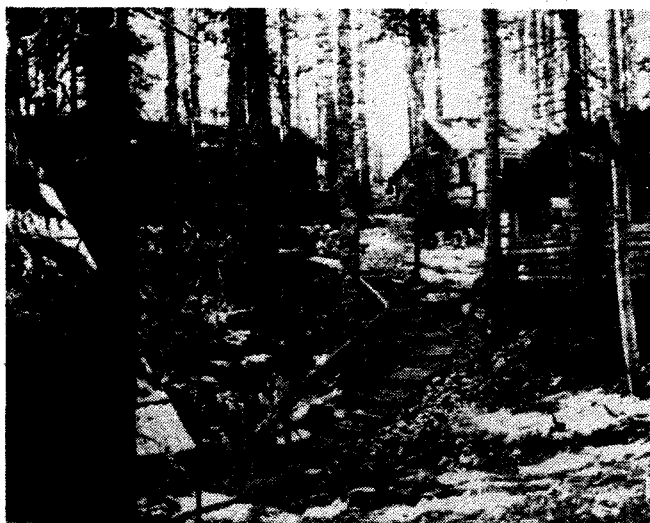
Zadnja zgrajena postojanka bloka SUPB »Pavla«, ki so jo imenovali postojanka »A« nad Krekovšem
