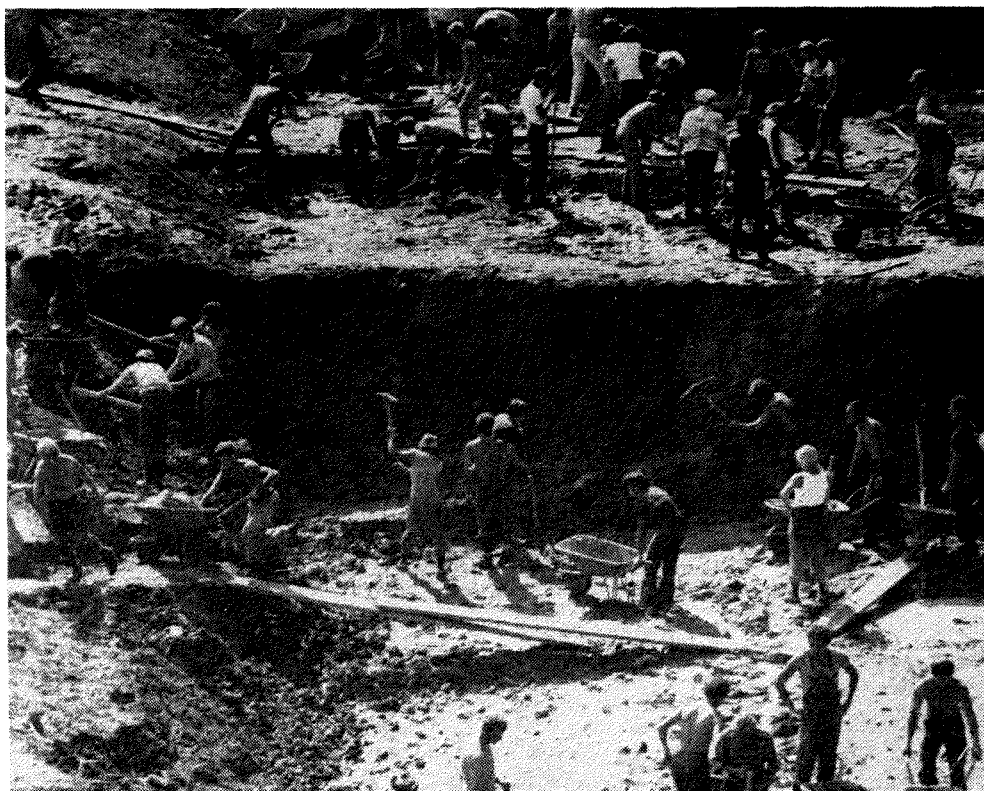
Mravljišče, ali gradbišče, imenovano Jugoslavija v malem.
