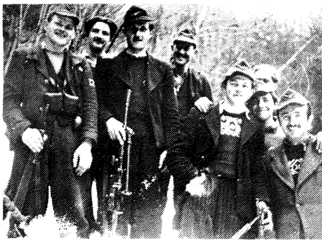
Polovica moštva minersko sabotažnega voda Grintovec
