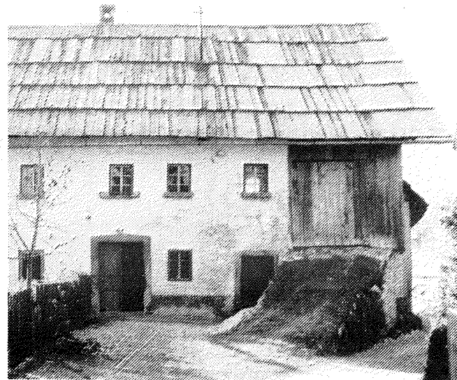
Hiša Tomaža Godca pred obnovitvijo.
