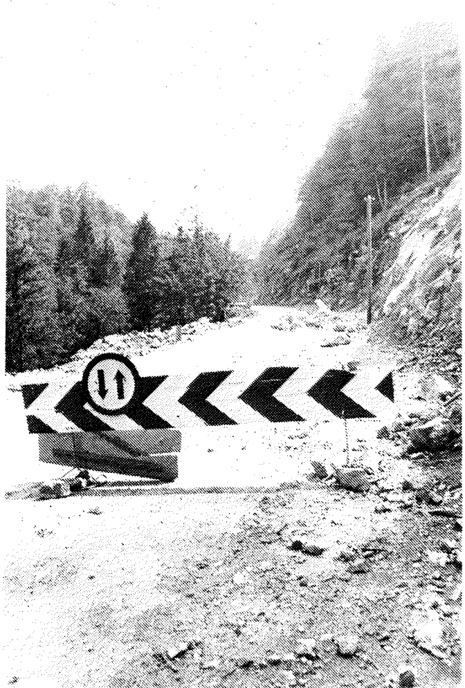
Se bo zemeljski plaz nad Starimi žagami kmalu umiril?
