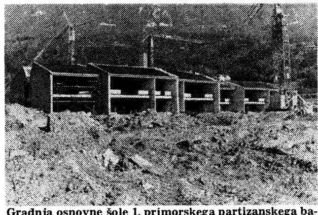
Gradnja osnovne šole I. primorskega partizanskega bataljona »Simon Gregorčič«
