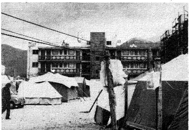
Bar: številni šotori, razsejani po gradbiščih novih blokov so tiste novembrske dni še delali napoto graditeljem.
