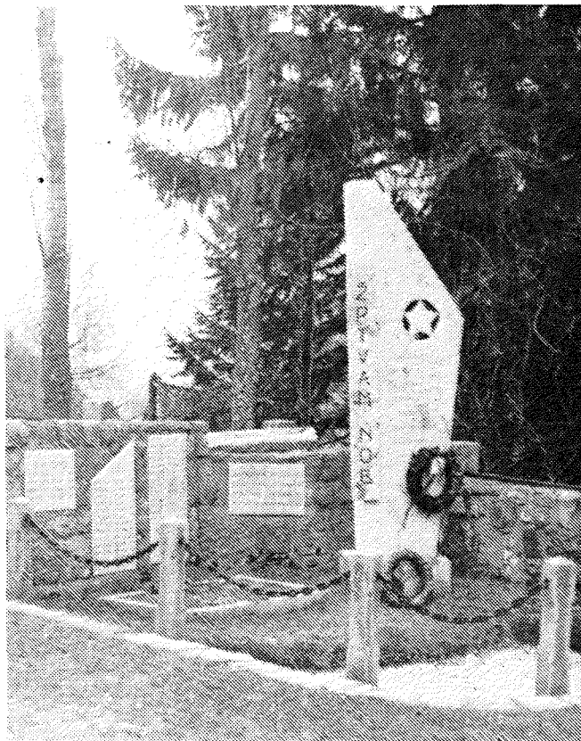
Grobišče na Bukovem je potrebno temeljitega popravila
