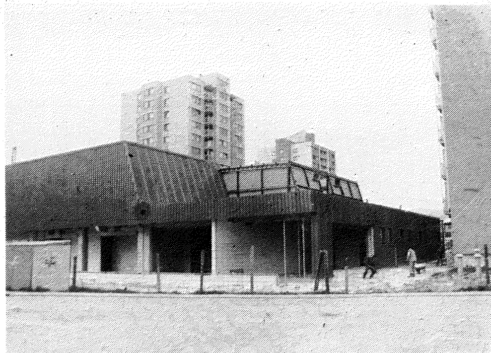
Novozgrajena trgovina se je zrinila med dve stolpnici in odžrla prostor jutrišnji generaciji. So v Celju pozabili, kaj pomeni otrok?
