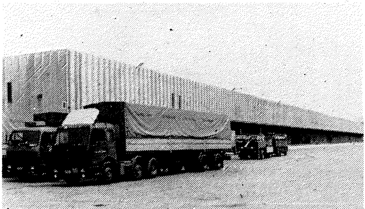
Javna skladišča Celje
