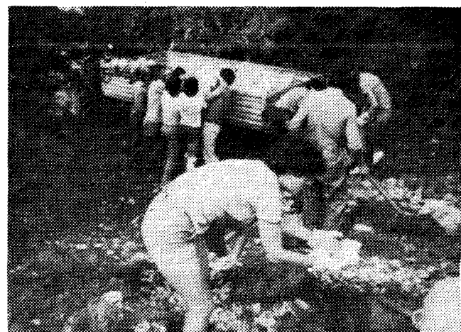
Najtežja dela opravljajo brigadirji pri čiščenju terena od grmičevja, kamenja. Tu so tudi poškodbe najbolj pogoste, zato uporabljajo zaščitno opremo
