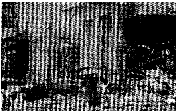
Sredi porušene bejrutske ulice
