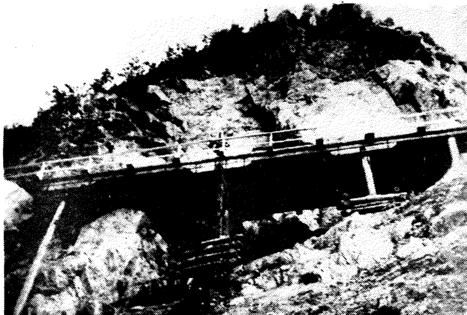
Most čez Kobilico med Spodnjo in Gornjo Trebušo. kot ga je naredila 1. četa 1. bataljona NOVGRADA KGVP v 16 urah 1944. leta
