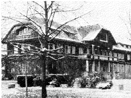
Šele 1924. leta je odprl zasebnik Čateške Toplice. Zidano-lesena stavba je že imela manjši bazen in kabine s toplo vodo.
