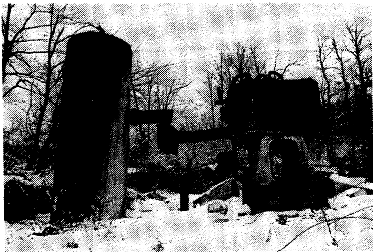
Še danes so na ogled ostanki razstreljenega kompresorja Borsig na območju jaška Zakov rudnika Senovo
