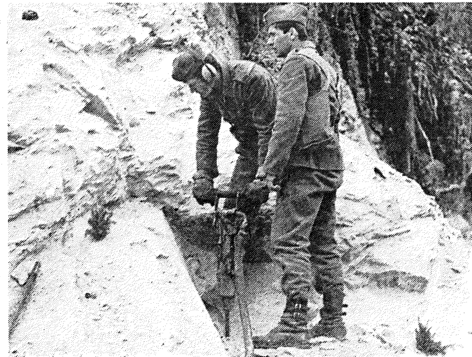
Na krajevni cesti Hrastje - Loka so vojaki razširjali ovinek. Odstranili so morali 1500 kubičnih metrov zemlje in laporja. Pri delu so inženirci uporabljali stroje, ki so vsi izdelani v domačih tovarnah.
