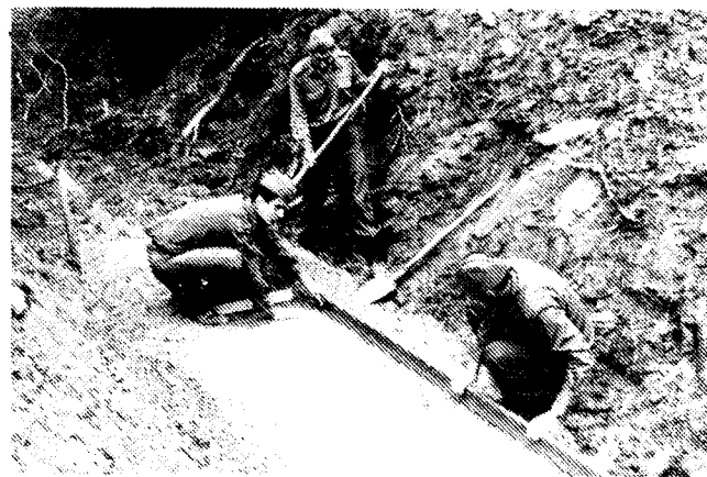
Vojaki Svetozar Todorović , Zrinko Pulić in Miodrag Radosavljević med pripravljanjem betonske podlage za odvodne cevi.
