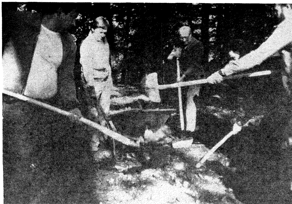
Tudi nekdanji sekretar SKOJ in sedanji predsednik RK SZDL Slovenije Jože Smole je prijel za lopato. Moč dejavnega zgleda nam bo potrebna ne samo na enem gradbišču, temveč povsod, kjer se razvoj ustavlja.
