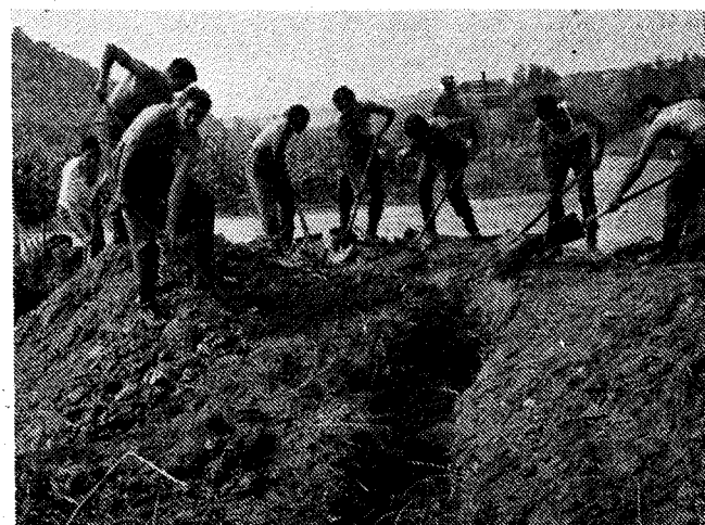
Graničarji s karavle Neblo med zasipanjem telefonskega kabla.
