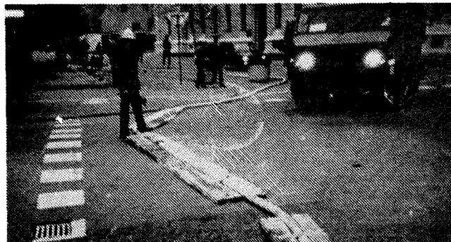
... na vseh križiščih in mestih, kjer so jih položili čez ceste, so jih zavarovali in tako zavarovali pred poškodbami ter omogočili nemoten promet.
