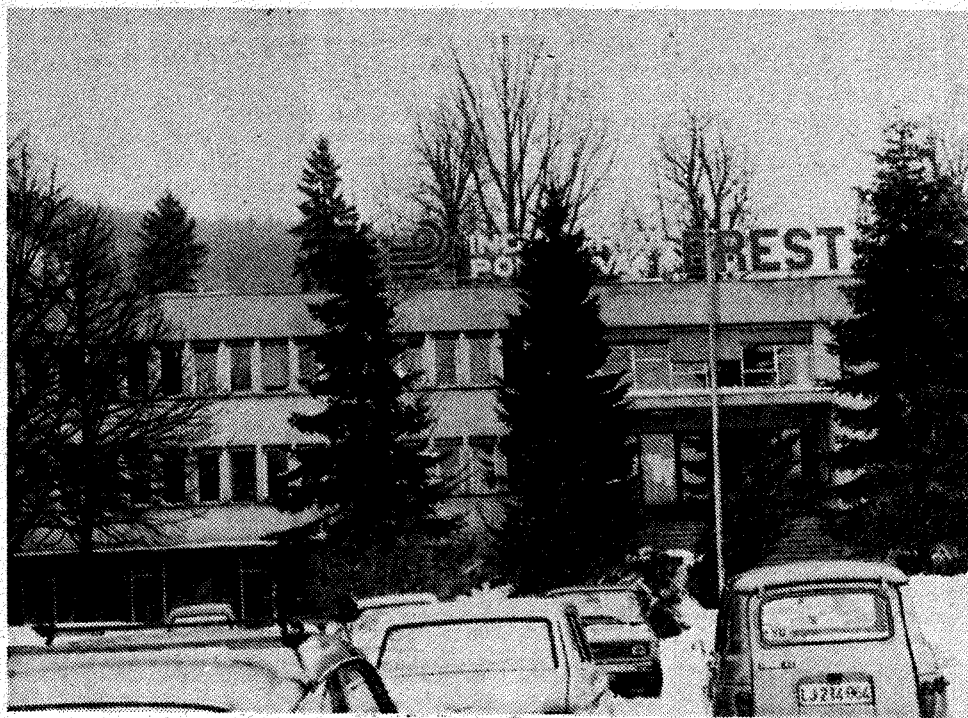
Upravna stavba cerkniskega Bresta
