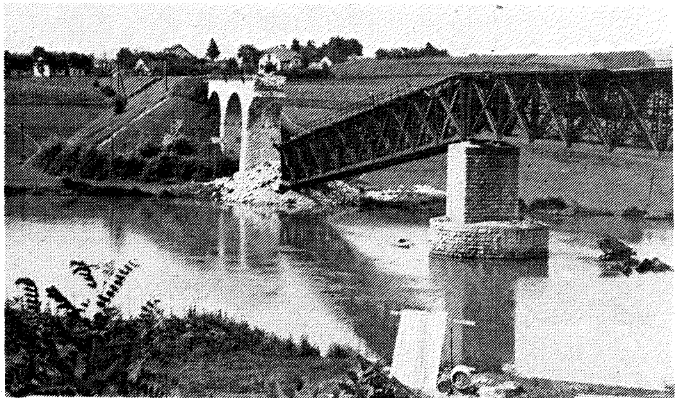
Porušen most v Kandiji.
