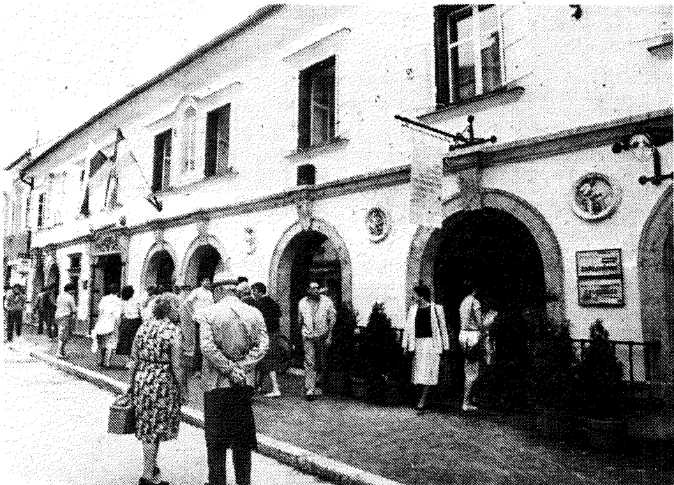
V starem stilu obnovljena zunanost Kovinotehnine trgovine.
