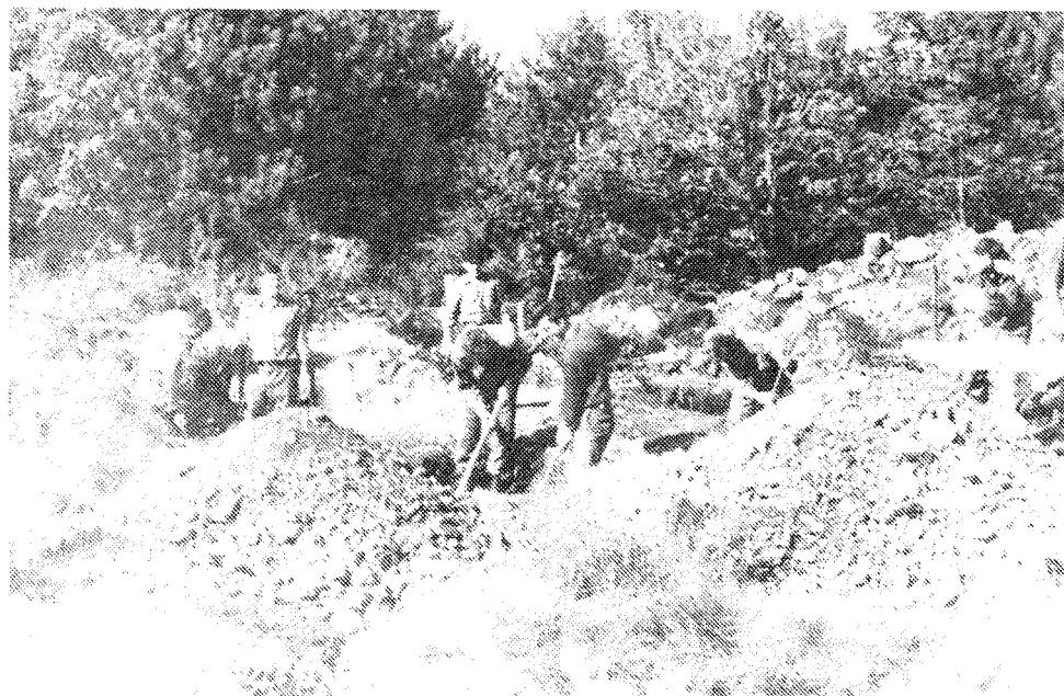
Na Trstelju morajo vojaki najprej izkopati temelje za bodoči televizijski pretvornik
