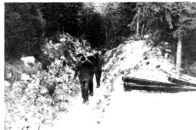
Skupaj z delavci SGP Primorje sestavijo cevi, zasujejo s peskom in zemljo, ali bolje povedano – s kamenjem.
