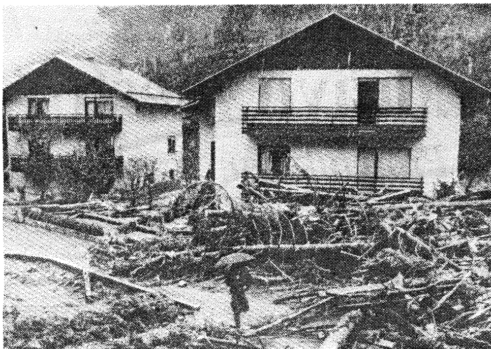
Vodna ujma, ki je prejšnji teden pustošila po Sloveniji je najhuje prizadela Zgornjo Savinjsko dolino predvsem Luče.
