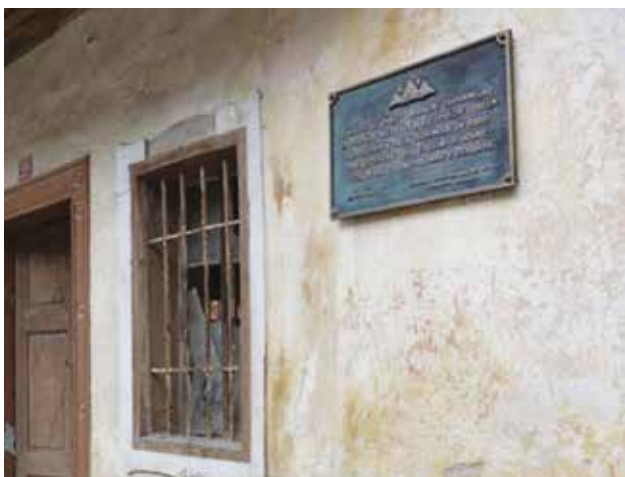
Fotografija hiše pred rušitvijo (vir: Arhiv KO ZB Bohinj).
