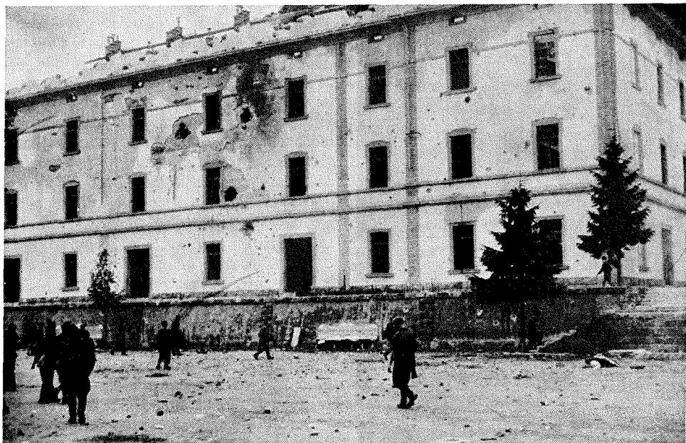
Dvorišče italijanske vojašnice v Cerknem, kjer je bila ustanovljena Vojkova brigada. Na steni so vidni sledovi preizkušnje protitankovskega orožja »partop«. Zdaj je v tej stavbi tovarna ETA
