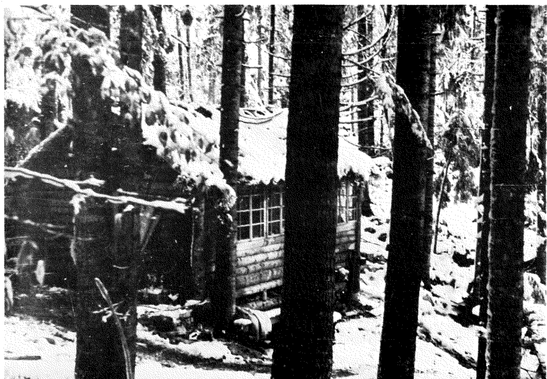
Spodnji Hrastnik, baraka za osebje in upravo, zgrajena verjetno med zimo 1943–1944.
