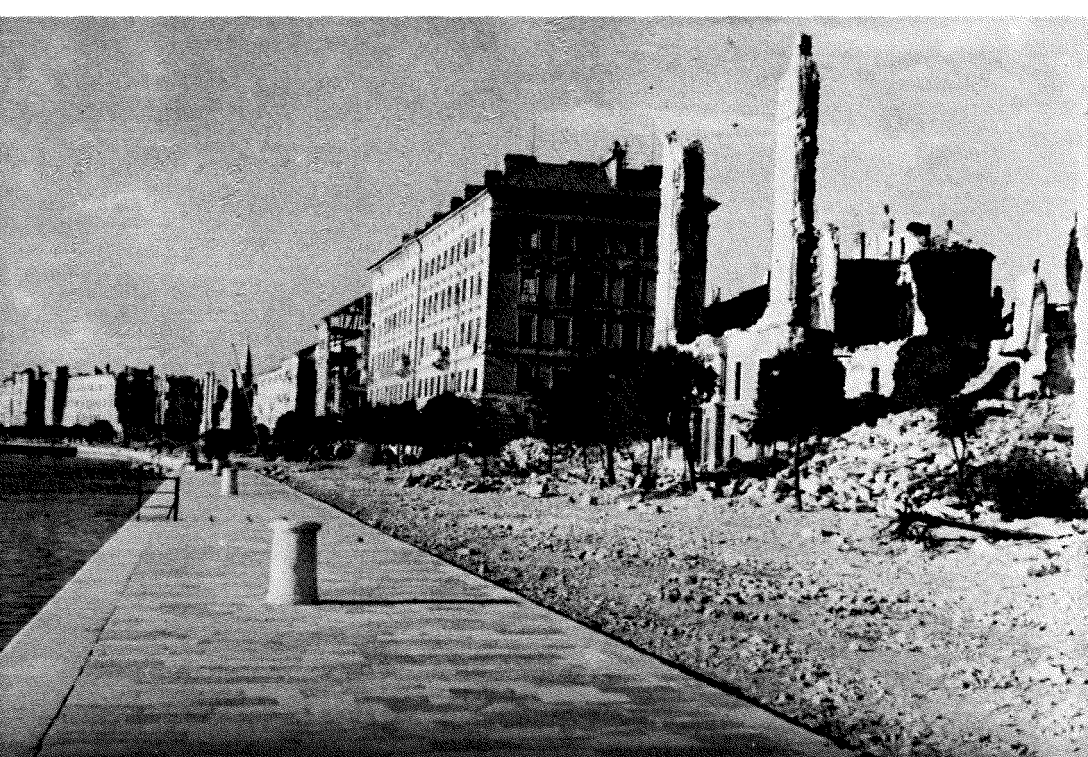
Razmeroma malo prizadeta zgradba hotela Bristol, pozneje Excelsior, danes Zagreb, je bila določena za bolnišnico.
