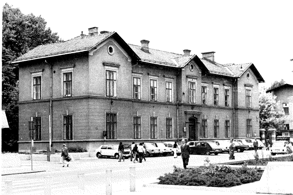
Upravna zgradba Obče državne bolnice na Zaloški cesti.
