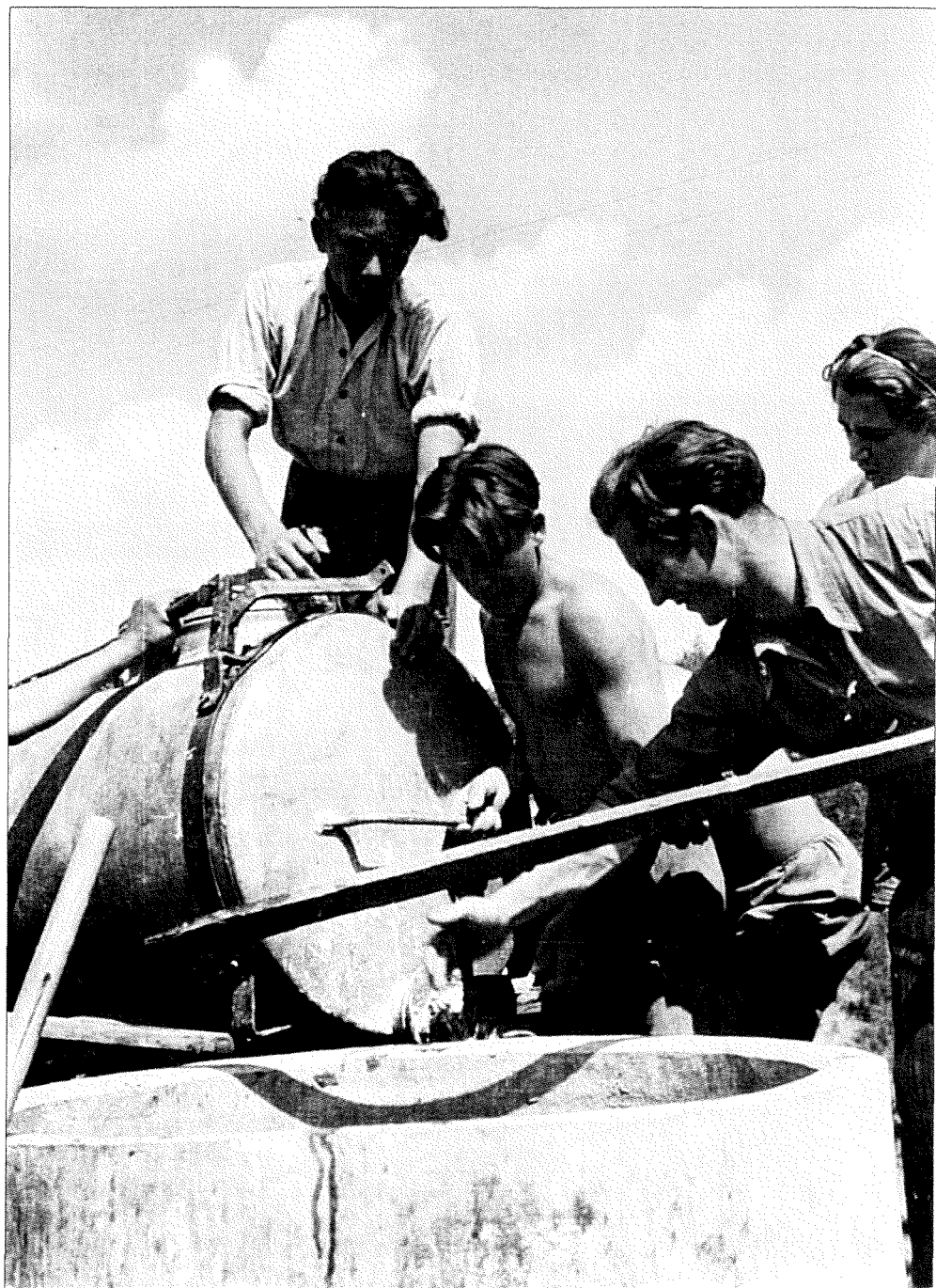
Na gradbišču Zadrúžnega doma v Kapeli julija 1947 (iz gradiva Muzeja novejšé zgodovine)
