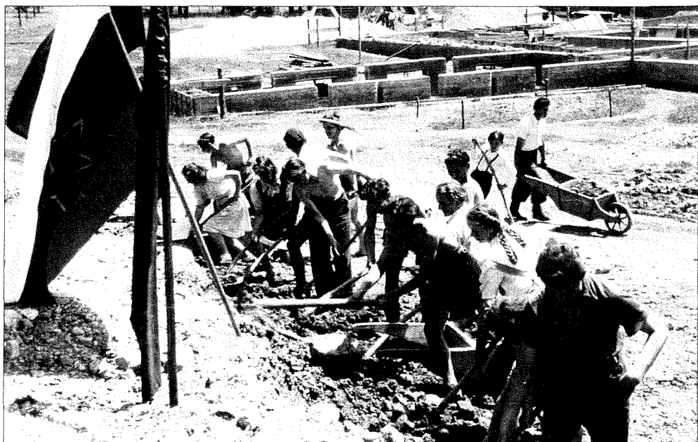
Prostovoljno delo pri gradnji šole v Dupljah pri Tržišču 6. junija 1948 (iz gradiva Muzeja novejše zgodovine)
