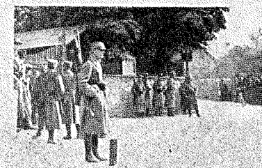
Zandarji na Javorniku (l. 1936)
