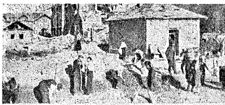
Pričela je obnova porušene domovine
